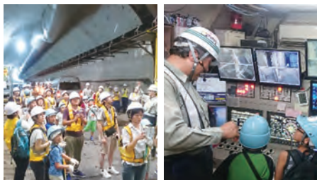
トンネル内を見回す参加者親子ら シールドマシンの運転方法について耳を傾ける小学生
